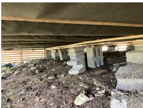
Alle pålene er side forskyvd om på utbedres.
