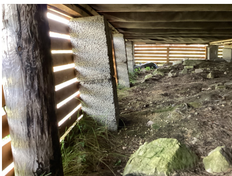
Alle pålene er side forskyvd om på utbedres.
