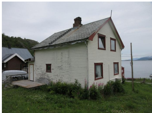
Fasade sør malingsslitt, takrenner og nedløp er skadet.
