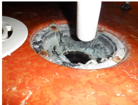
Plastsluk med klemring.
