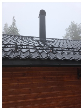
helbeslått pipes med regnskjerming
