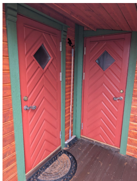
Yttedør til venstre, boddør til høyre.
