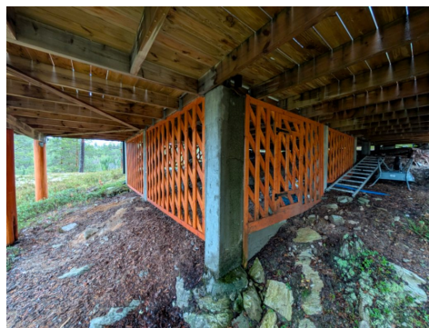
Steinreir fra støping
