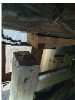
Gulvbjelke er dårlig understøttet
