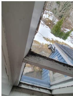
Målt fukt i kjøkkenvindu 31.6V%.
