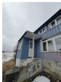
Takvinkel er for liten for denne type tekking.
