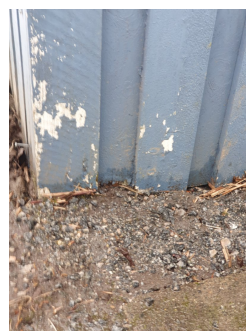
Kledning går stedvis ned på terreng.
