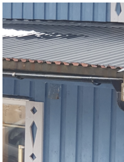
Takplater har rust i nedkant mot takrenne.
