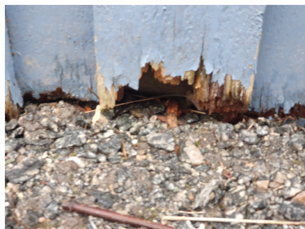
Råteskadet kledning.
