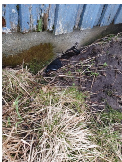
Betongmur på tilbygget mot nord.
