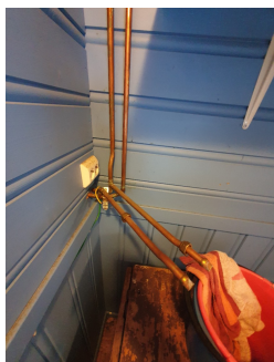
Åpne rør der varmtvannsbereder skal stå
