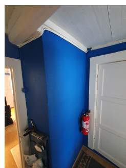
En side av pipe er kledd med plater, gjelder plassbygget skap mot kjøkken.
