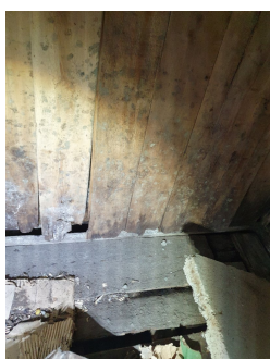
Gulvbjelke er dårlig understøttet
