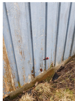
Kledning går stedvis ned på terreng.
