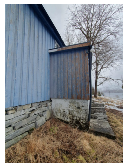
Betongmur på tilbygget mot sør.
