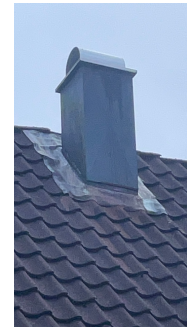
Pipehatt med aldringstegn/værslitsasje
