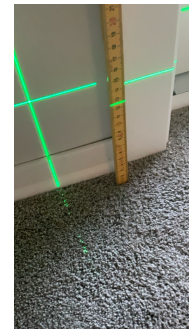
Høydeforskjell - gulvflat, soverom
