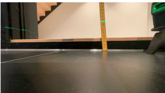
Oppkant opplyst etablert ved dør - min. 15 mm
