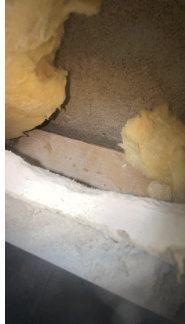
Ikke synlige tegn til at det har oppstått skader på kontrollert sted i veggen
