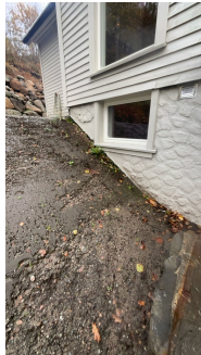
Synlig grunnmursplast over terrengnivå
