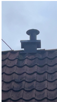
Takbeslag dårlig tilpasset taktekingen.
