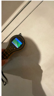
Overflatesøk i dusjnise - gulvflate
