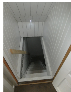
Bildet viser trapp ned til kjeller.
