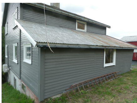
Bildet viser terreng inn mot bygningen på øversiden.
