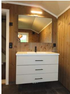
Servantskap med helstøpt servantplate med ett-greps blanebatteri.
