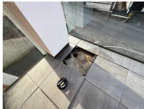
Her ser man hvor sluket er etablert under steinhellen.
