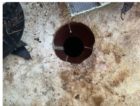
Her ser man hvor sluket er etablert under steinhellen.
