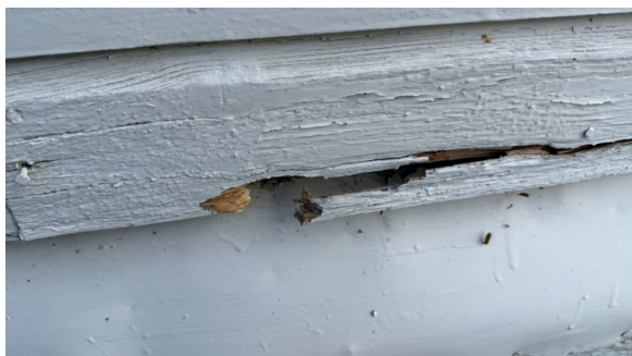
Eksempel på råteskadet fasade/kledning
