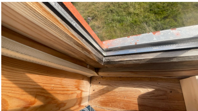
Kondenssitasje vindusramme
