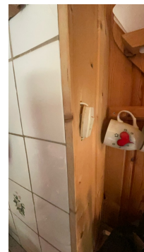
Ufagmessig el-arbeid (ser ikke ut å være fast tilkople, men på stikk)
