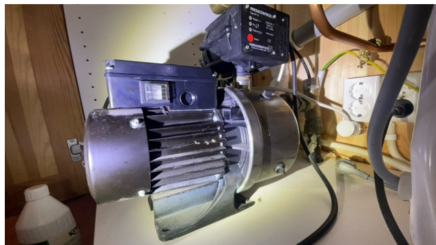
Vannpumpe kjøkkenbenk
