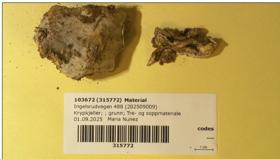
Foto 1. Prøve 315772. Stein og soppmateriale, krypkjeller, grunn.
