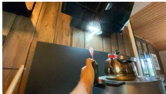
Sjekk med røy
