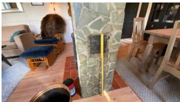
Brennbart gulv under sotluke
