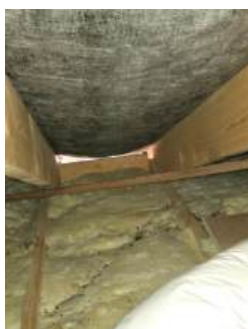
Undertak er ikke tett mot pipe.
