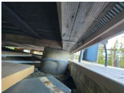
Støpte søylepunkter mot sør.
