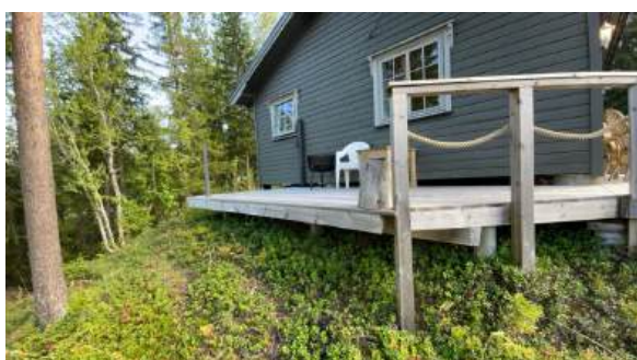
Mangler rekkverk
