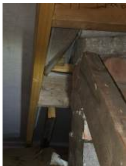
Undertak er ikke tett mot pipe.
