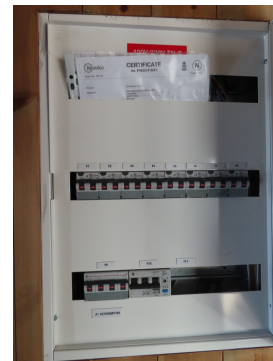
Skap med sikringsautomater i vegg mot bad.
