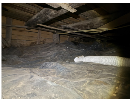
Plastduk på jordgulv er et fint tiltak mot fukt.
