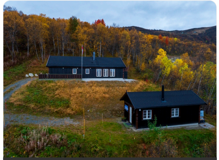
Fasade mot syd og annekts til høyre
