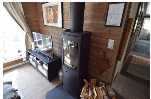
Peiovn med stålpipes
