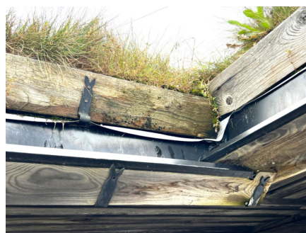
Torvstokksbord - Innvendig hjørne ved hovedinngang.
