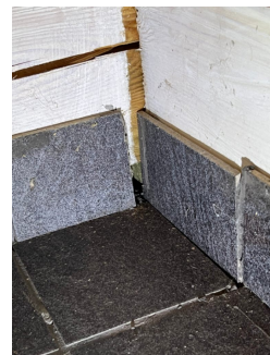
Ingen membran/oppkant bak sokkelfiser langs vegger
