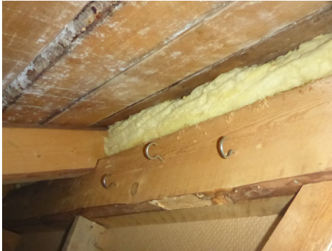
Viser del av taket som er uten lufting.
