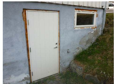
Viser kjellerdør uten innpusning/belistning.
