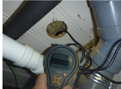
Viser utført fuktmåling fra undersiden av badet uten å avdekke unormale verdier av fukt.
