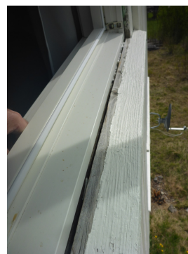
Viser uheldig løsning med vannbrett under vindu.
