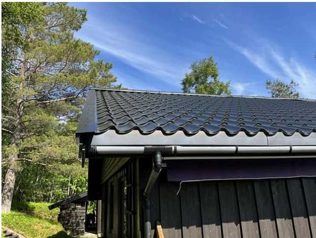
Renner og nedløpsrør av plast.
