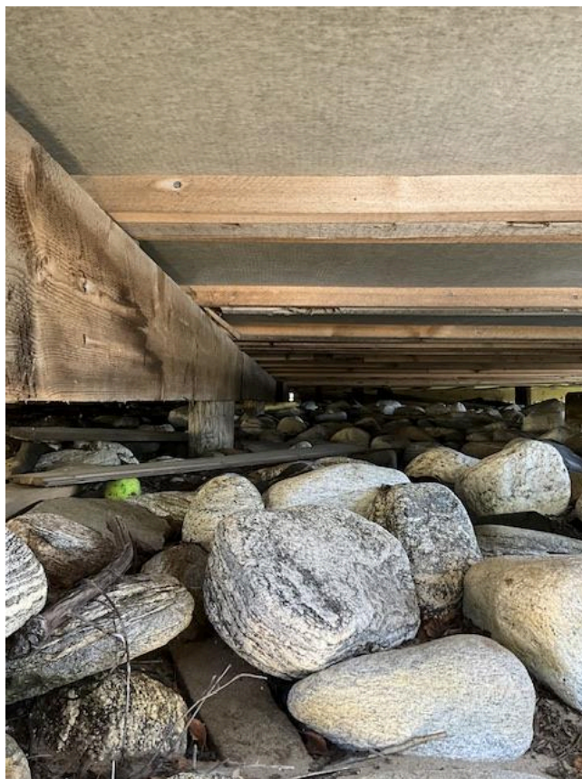
Stubbgulv med asfaltflate.
