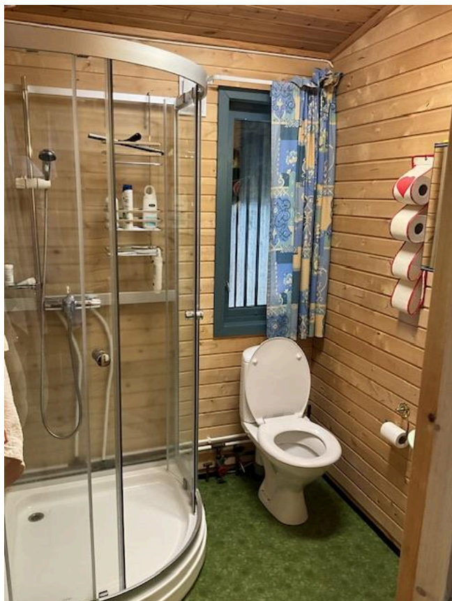
Baderom med hovedstoppekran imellom dusjkabinett og wc.
