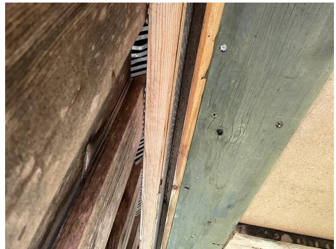
Lufting bak kledning og musebånd.
