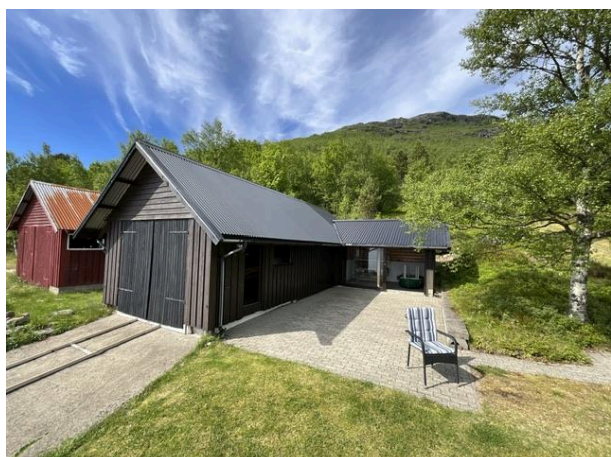
Naust med lukked uteplass og lagerrom.
