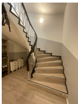
Betongstøpt trapp med rekkverk i stål.
