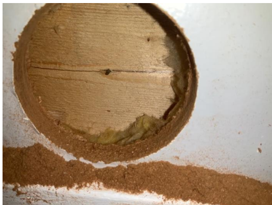
hull for inspeksjon, ingen avvik
