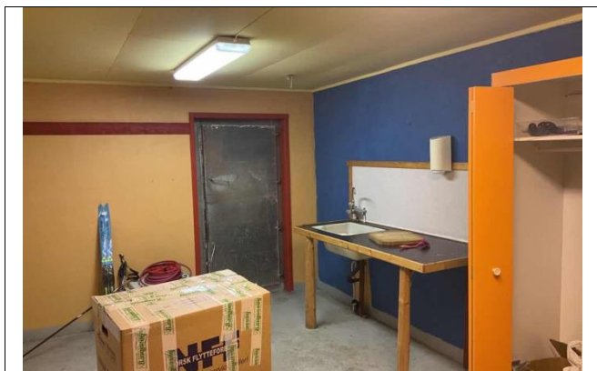
verksted med uisolert dør til garasje (ståldør)
