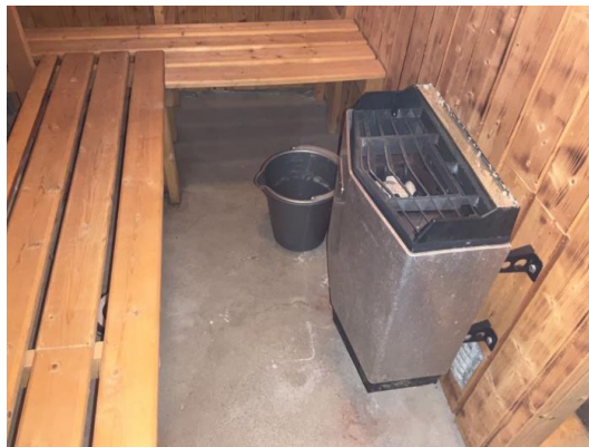
badstue med elektrisk badstueovn
