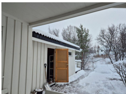
Veranda med utgang fra stue.
