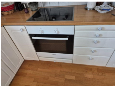
Kjøkkeninnredning med profilerte fronter.
