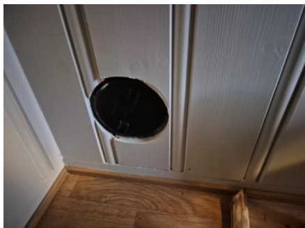
Stakeluke i vegg i bod i u. etg..
