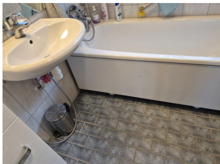
Flislagt baderomsgulv. Tilnærmet flatt gulv.
