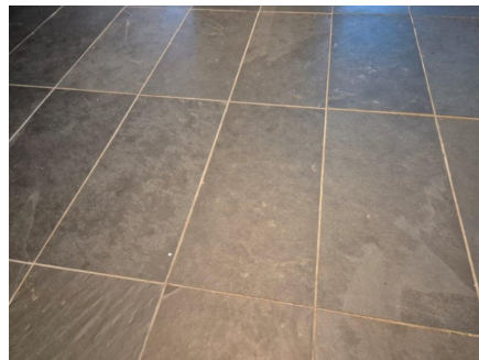
Flislagt gulv i hall i underetasje.
