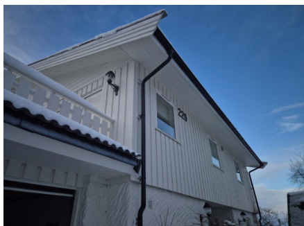
Takrenner og nedløpsrør i stål.
