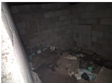
Krypjkjeller under deler av boligen.
