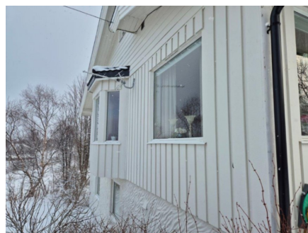
Utvendig kledning av malt tømmermannspanel.
