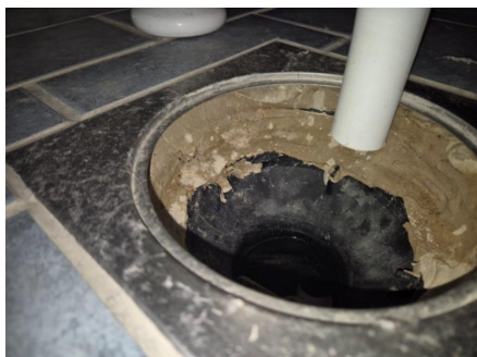
Plastsluk. Mansjett er ført ned og limt til sluk og påført smøremembran.
