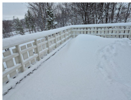
Veranda over garasjetak.
