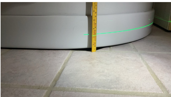
Målt fall til sluk: 10mm
