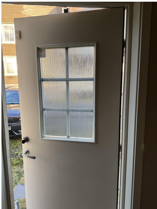
Ytterdør i laminert utførelse med glass felt.
