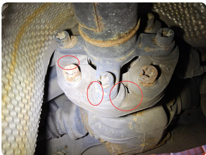
7.1 Defekt balatakobling/balanselodd mellomaksling Sprekkdannelser.
