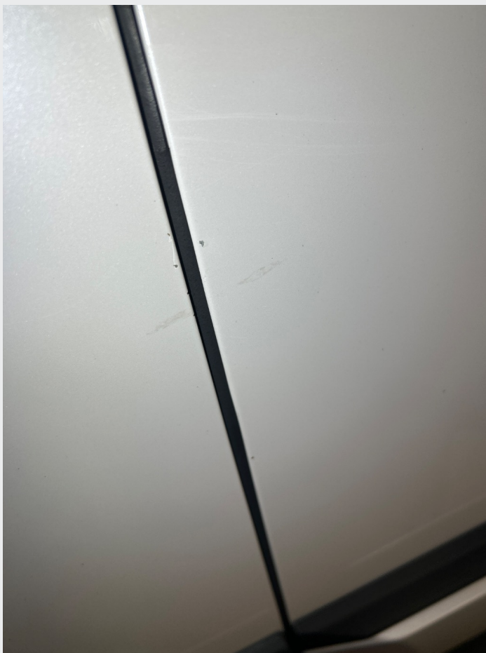
2.1 En del steinsprut og riper rundt om
