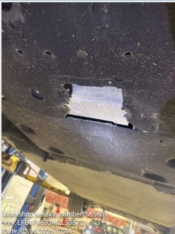
2.2 flere av plater under bil er skadet
