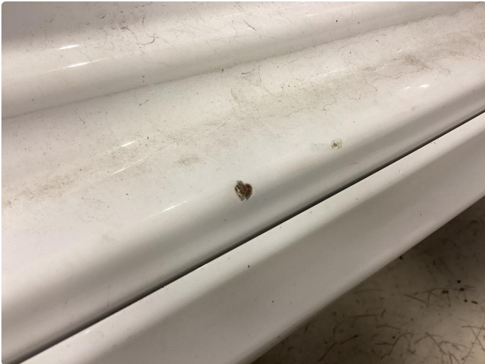
1.1 Liten bunkel med lakkskade
