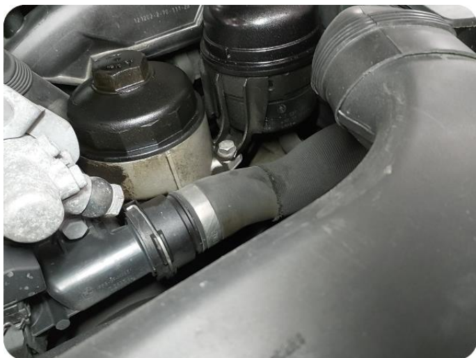
5.3 Oljelekkasje i forkant
