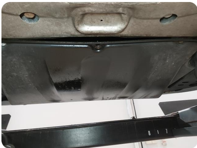
5.4 Oljelekkasje mellom motor/gear
