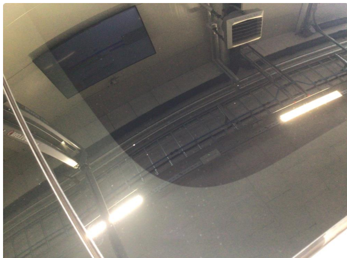
1.1 Noe steinsprut på takluke
