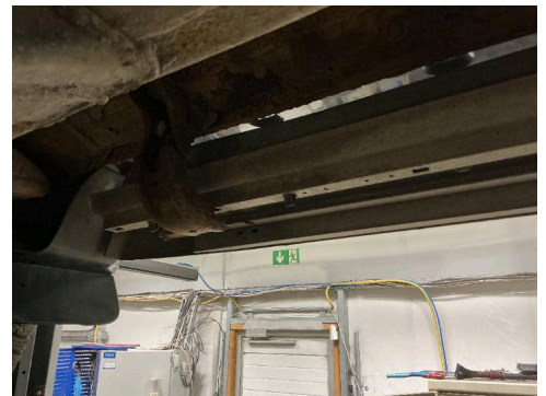
R 36. Høyre kanal
