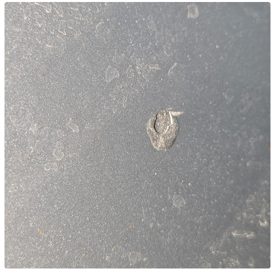
1.2 Noe steinsprut på dører, blitt penslet m/lakk
