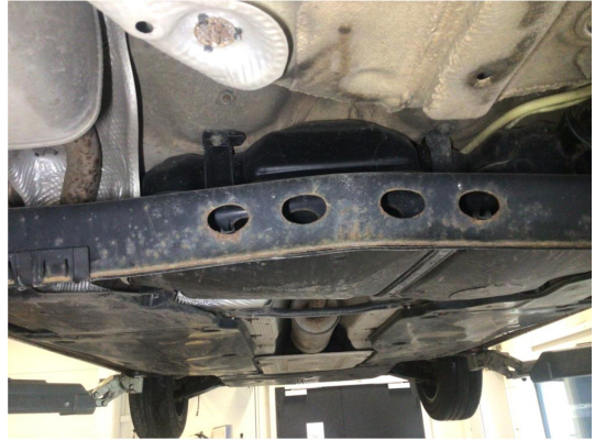
2.1 Noe overflaterust i bakstilling, ingen tiltak kreves
