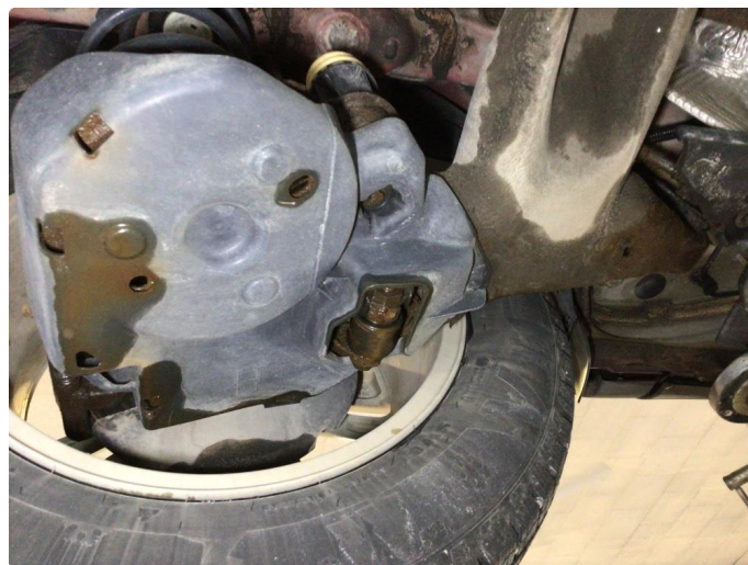
2.1 Overflaterust i bakstilling, ingen tiltak kreves
