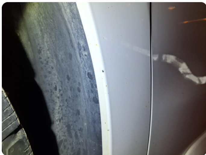
3.1 Generelt mye stensprut Og hakk/små riper
