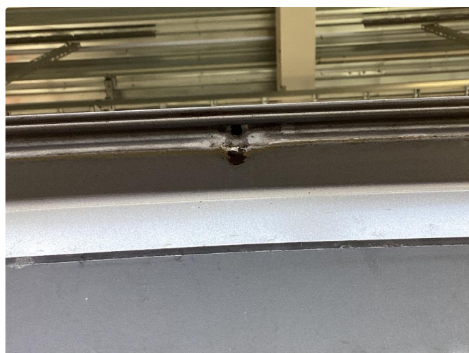
1.4 Rust/korrosjon
