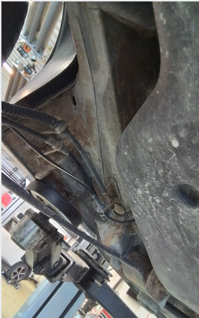
2.2 Rust travers foran og noe under bilen
