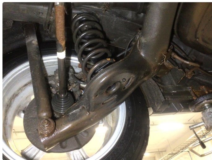
2.2 Overflaterust i bakstilling, ingen tiltak kreves
