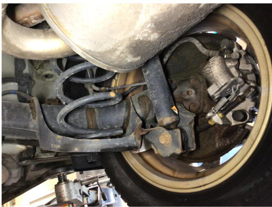
2.2 Overflaterust i bakstilling, ingen tiltak kreves
