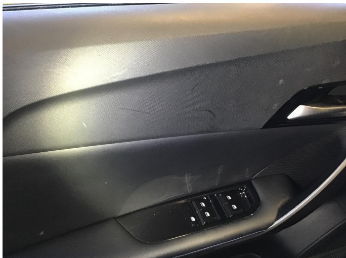
1.1 Skadet/merker etter utstyr
