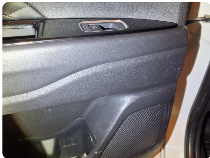
7.1 Øvrige feil Noen riper og flekker interiør
