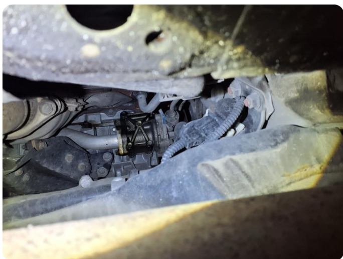
5.1 Svetter Feilsøk. Må kontrollerer på verksted og yttligere kostnader kan tilkomme
