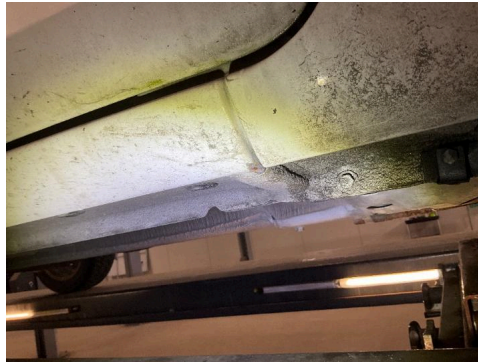
R 26. Høyre kanal
