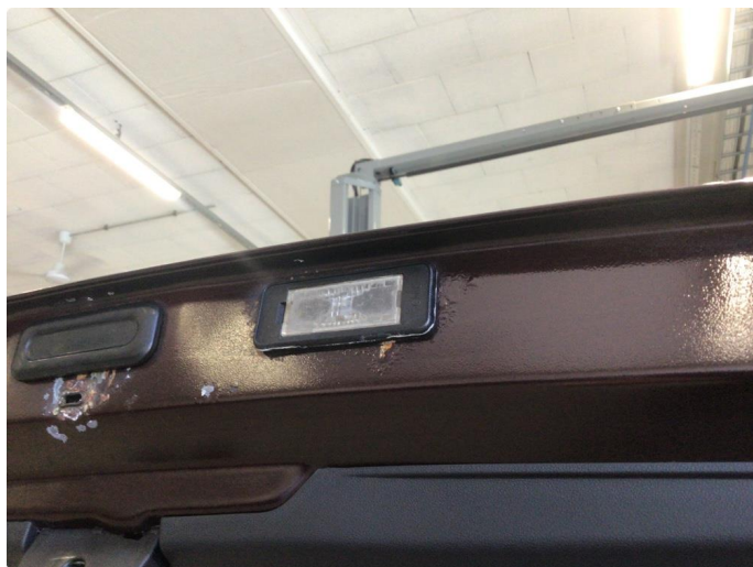
1.4 Noe korrosjon på innsiden av bakluke, dette av minimal betydning
