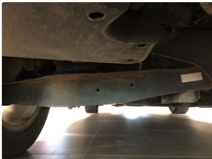
2.1 Overflaterust i bakstilling, ingen tiltak kreves
