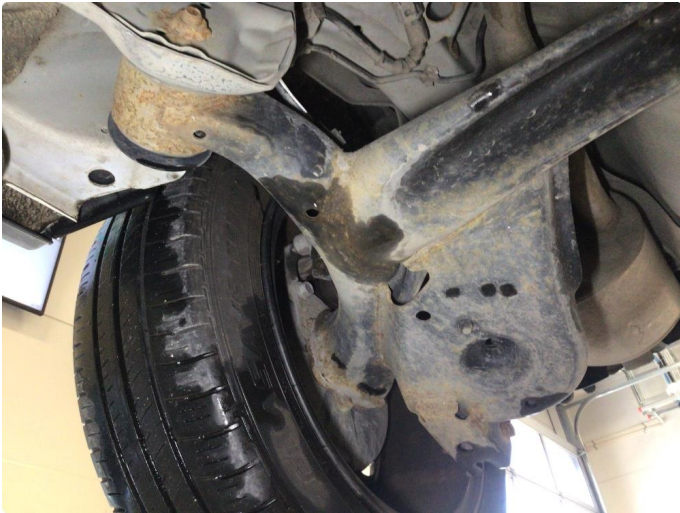
2.1 Overflaterust i bakstilling, ingen tiltak kreves
