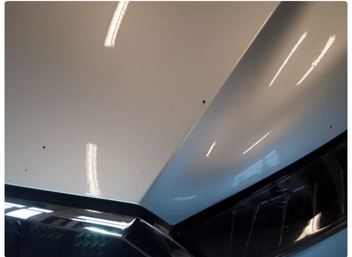
1.2 Noe steinsprut med korrosjon.
