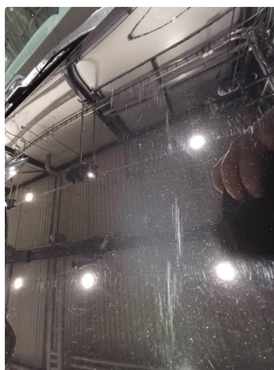
1.1 Noen riper og småbulker
