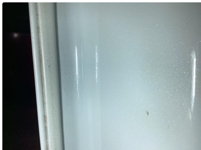
1.1 Rust i fals
