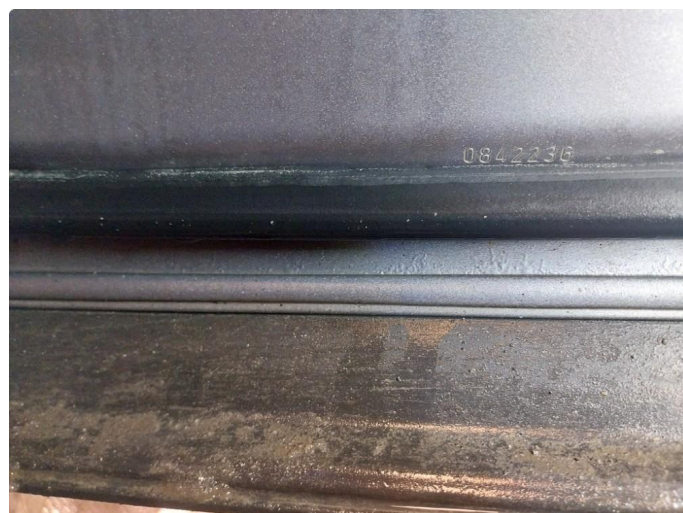
1.3 Rust i fals
