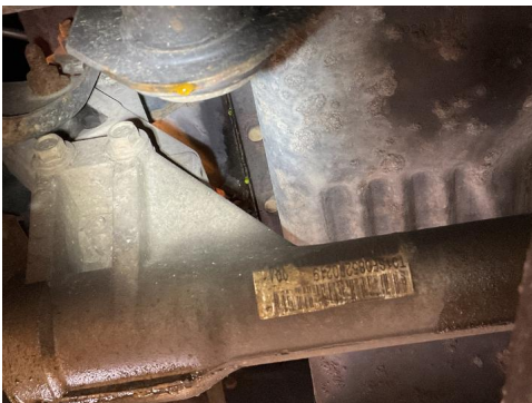
58. Utvendig tilstand motor
